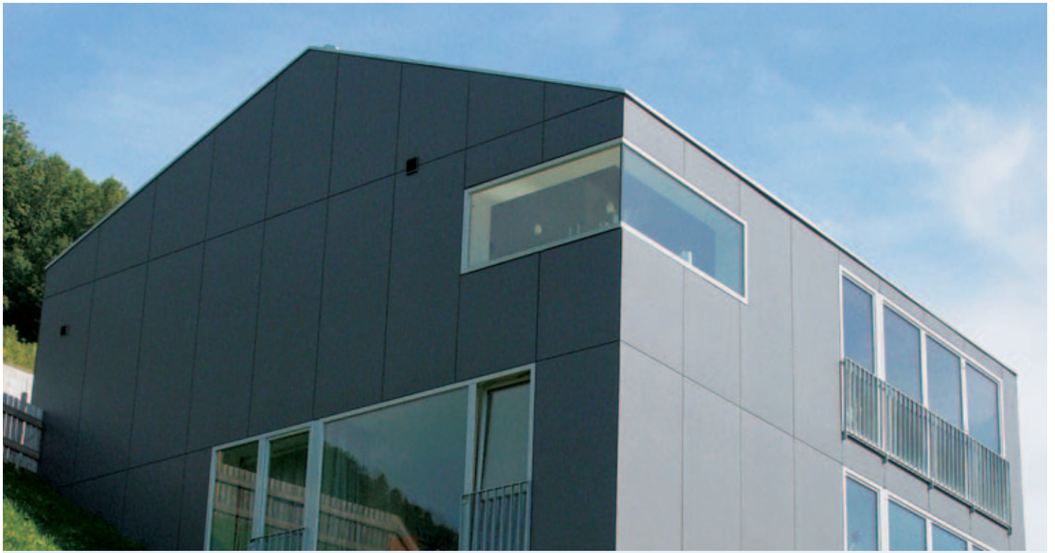
FAÇADE EN FIBROCIMENT
